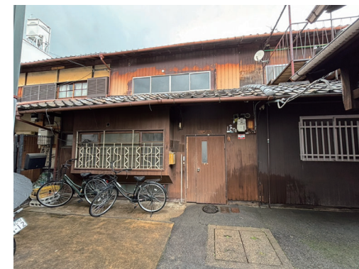
▲A 棟現況写真
