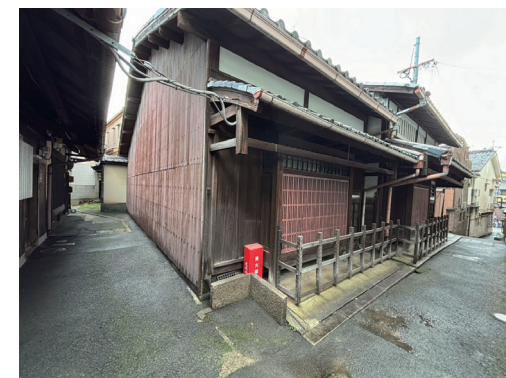
▲D 棟現況写真
